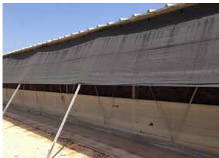
شکل ۶. سایه بان متخلخل که مانع تابش مستقیم نور آفتاب به داخل سالن بوده اما اجازه به ورود جریان هوا می
