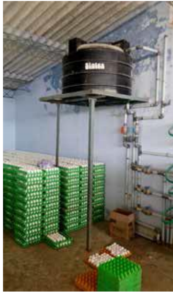
شکل ۹. نصب مخزن آب درون سالن سبب خنک تر ماندن دمای آب درون آن خواهد شد
