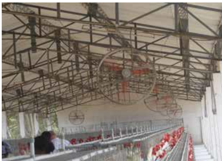
شکل ۲. فن های جابجا کننده هوا و مه پاش ها سرعت جریان هوا را در داخل سالن افزایش داده و ایجاد اثر خنک کننده می کنند
