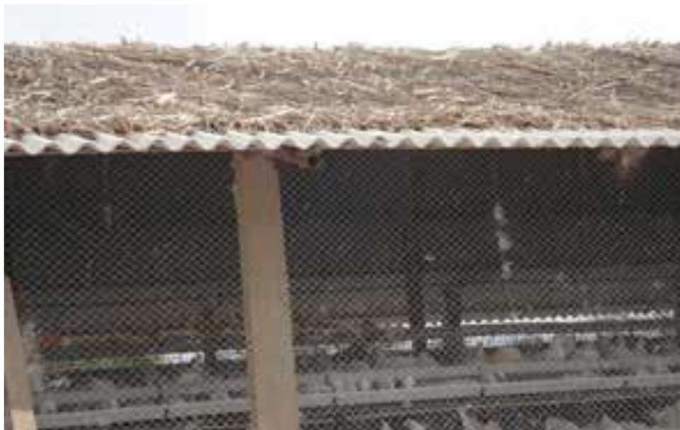
شکل ۵. استفاده از کاه و علوفه (نی برنج، ساقه ذرت، نیشکر) با هدف کاهش تابش گرما از سقف
